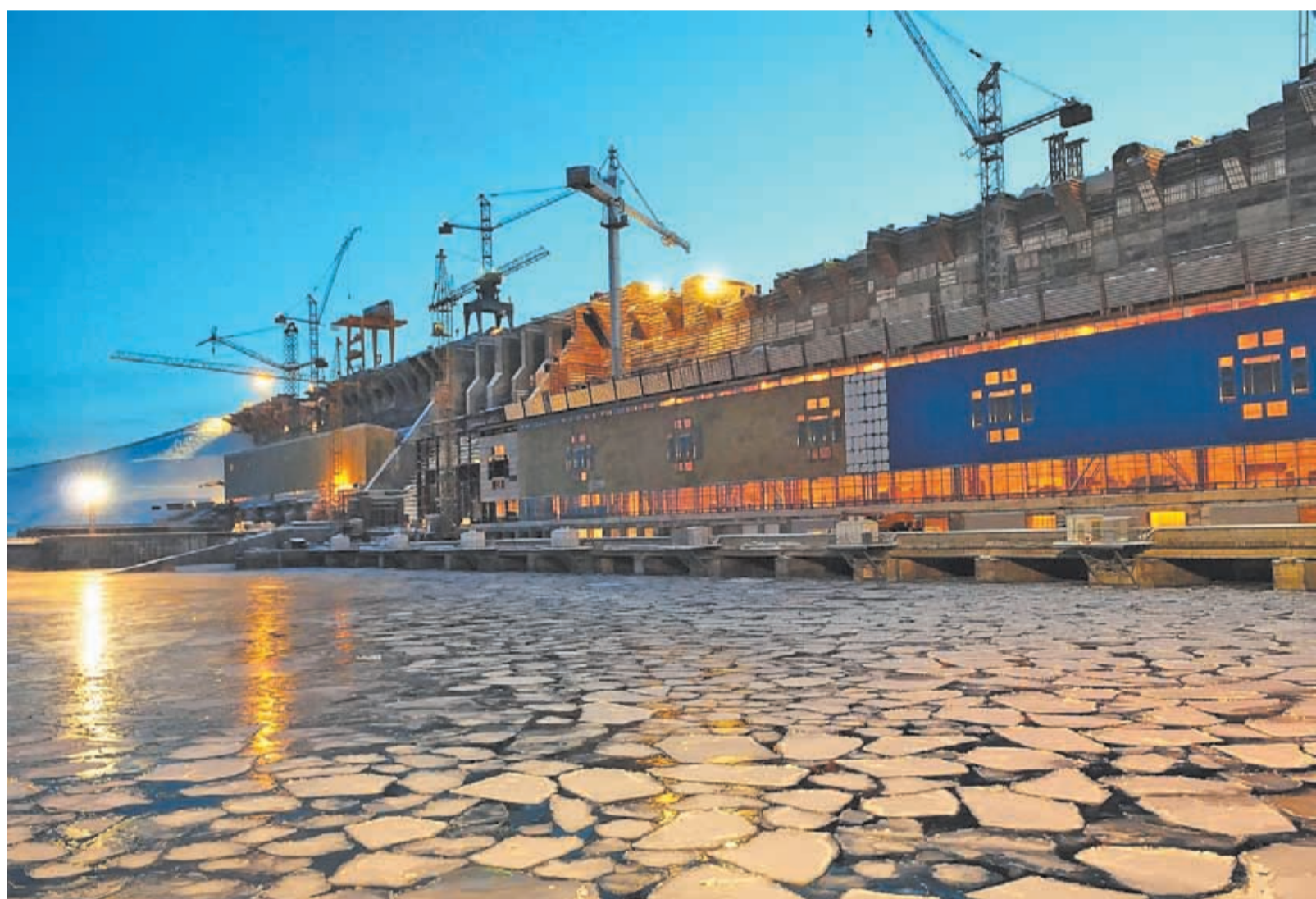
Плотина Богучанской ГЭС подготовлена к заполнению водохранилища
